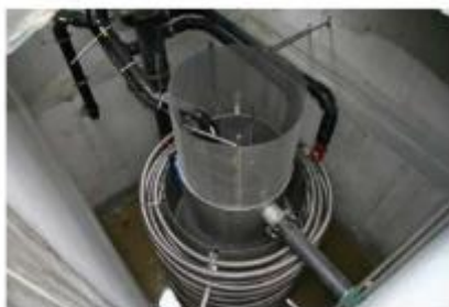
Figuur 7 – Warmterecuperatie via opslagvat met geïntegreerde warmtewisselaar (links) en vat in vat-systeem (rechts)
