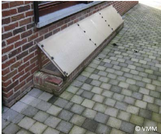
Een bestaande gemetselde verluchtungskoker verhogen
