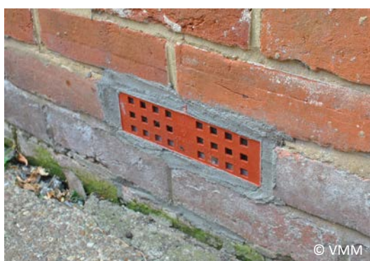
Automatisch afsluitbaar verluchttingsrooster
