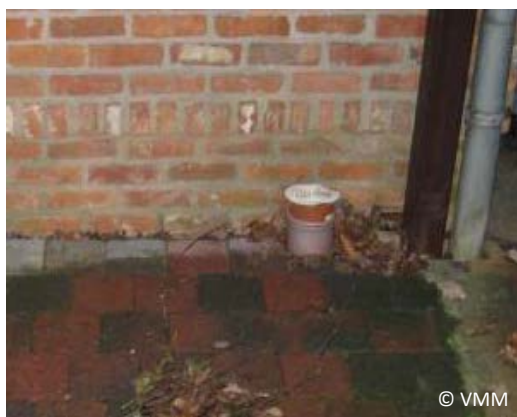
Een bestaande verticale verluchtungsbus verhogen
