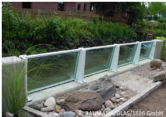
Glaskader op consoles verankerd in een betonnen keermuur
