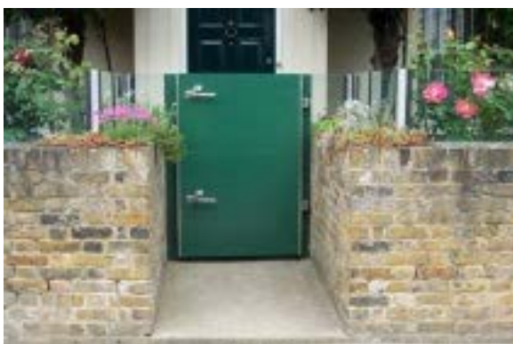
Een gemetselde keermuur met geïntegreerde waterdichte poort
