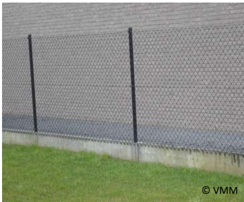
Betonpanelen gecombineerd met een tuinafsluiting
