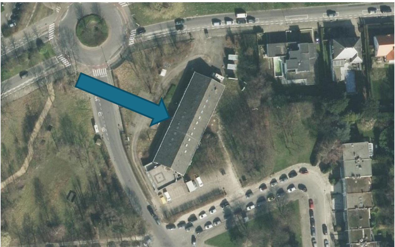
Figuur 2: VMM-gebouw Vuurkruisenplein
