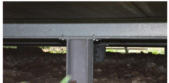
Figuur 16 (boven) - Stalen rooster op de stalen kolommen, waarop de vloerplaat verder opgebouwd is met betonnen welfsels. Onder de woning is een open ruimte van 40 à 50 cm hoogte, met daaronder de funderingszolen waarop de stalen kolommen vastgezet zijn.
