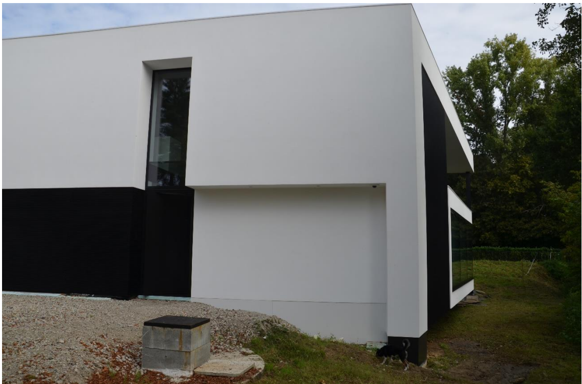
Figuur 10 - Woning met uitkraging van de leefruimte boven wachtbekken, en waterdichte kelder (ARCHITECTENBUREAU STIJN JANSSENS BVBA)
